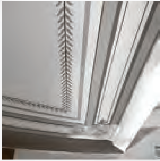
Återskapad takmålning på Esplanaden 4. Längst ner i bild syns en bit av originalmålningen.
